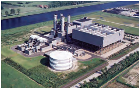
Bruges , Бельгия — Конденсатор с воздушным охлаждением для парогазовой установки мощностью 460 МВт.
