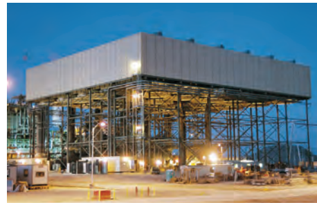
Ареx , США — Конденсатор с воздушным охлаждением для парогазовой установки мощностью 500 МВт.
