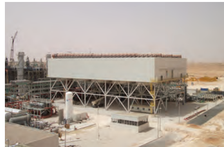
Hassi R'Mell , Алжир — Конденсатор с воздушным охлаждением для парогазовой установки мощностью 150 МВт – Солнечная электростанция.
