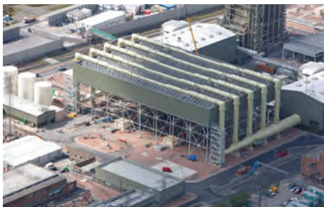
evern , Великобритания — Конденсатор с воздушным охлаждением для парогазовой установки мощностью 2x400 МВт.
