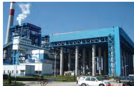
Wuxiang , Китай — Конденсатор с воздушным охлаждением для угольной электростанции мощностью 2x600 МВт.
