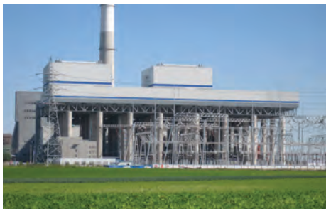
Baicheng , Китай — Конденсатор с воздушным охлаждением для угольной электростанции мощностью 2x660 МВт.
