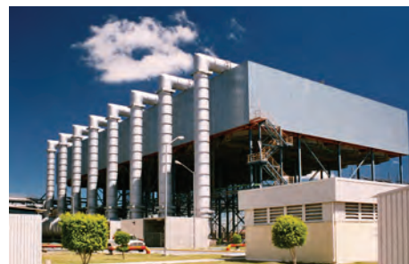
Rio Bravo , Мексика — Конденсатор с воздушным охлаждением для парогазовых установок мощностью 3x515 МВт.
